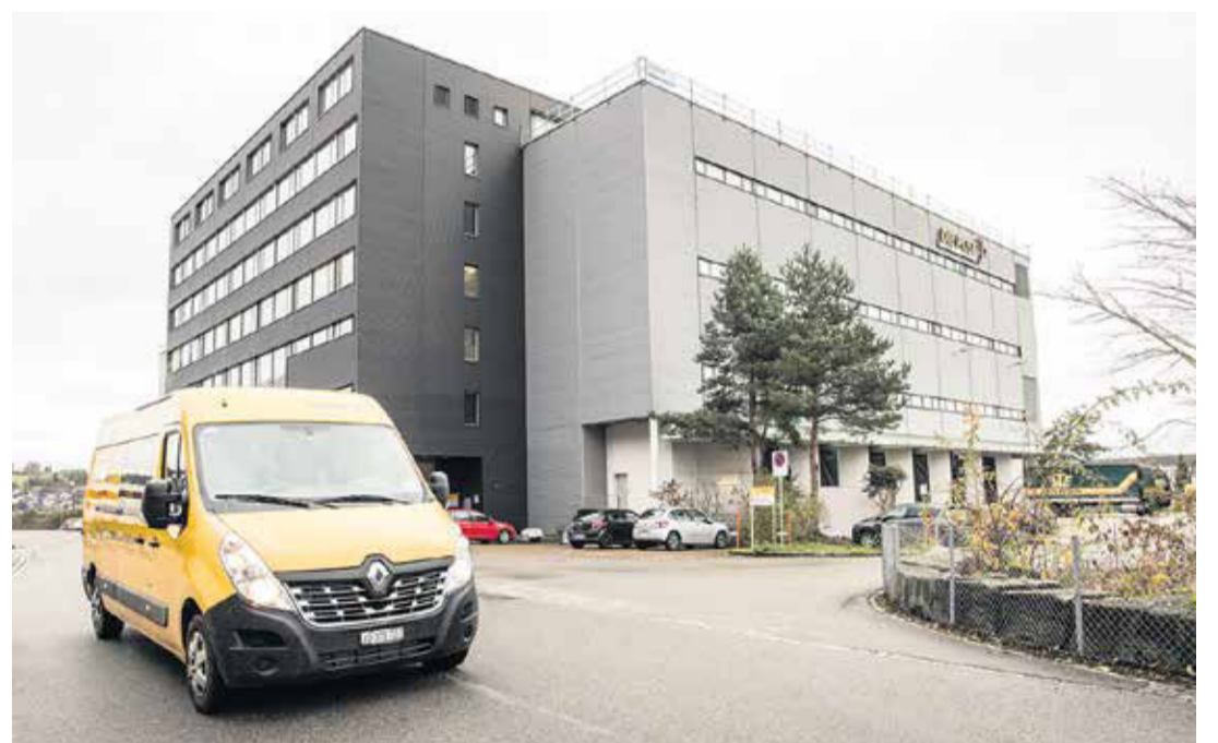
Die Photovoltaik-Anlage auf dem Dach des Logistikzentrums Villmergen ist in fünfzehn Jahren amortisiert.
